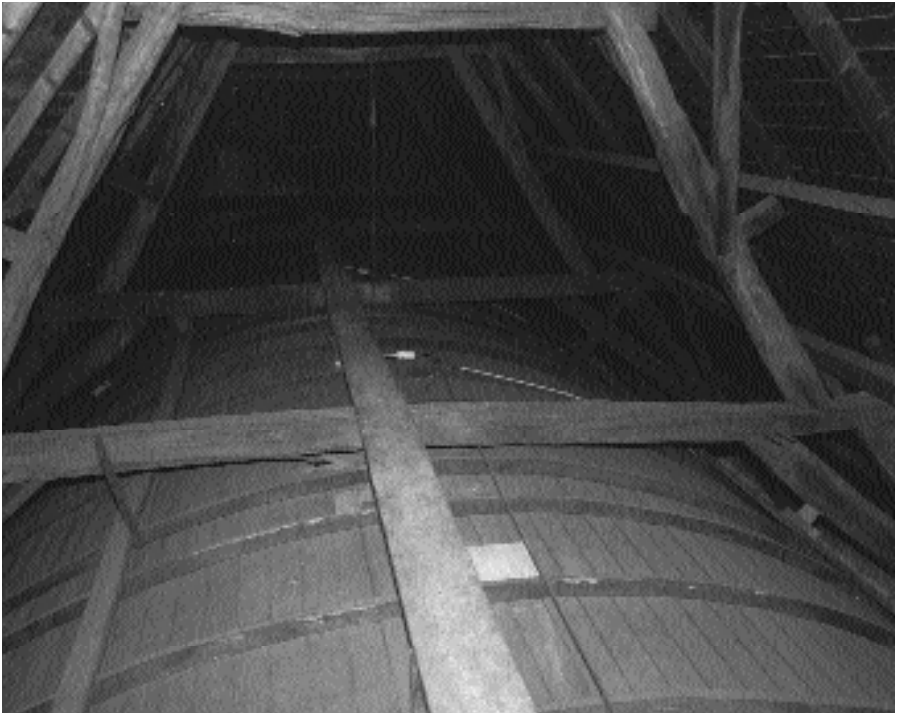
De unieke dakconstructie die ertoe heeft bijgedragen dat de kerk werd aangewezen tot rijksmonument.
