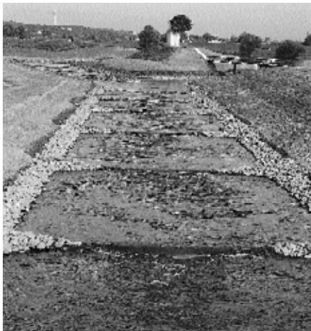
Vistrappen maken het voor trekvisseren mogelijk om stuwen en andere obstakels te passeren. Vooral zalm, die tot zes meter uit het water kunnen springen, hebben daar zeker geen enkele moeite mee
