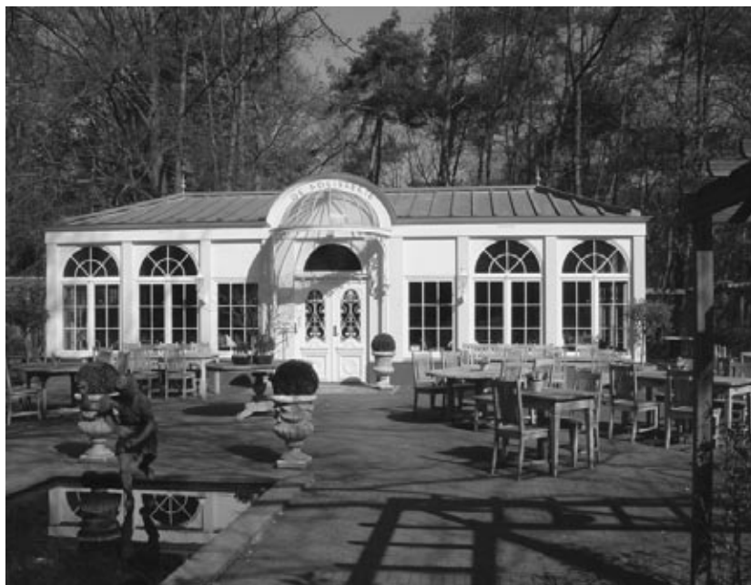
De orangerie in 2006. aan de vijver staat het bronzen beeld dat in 1990 bij de (her)opening werd geplaatst
