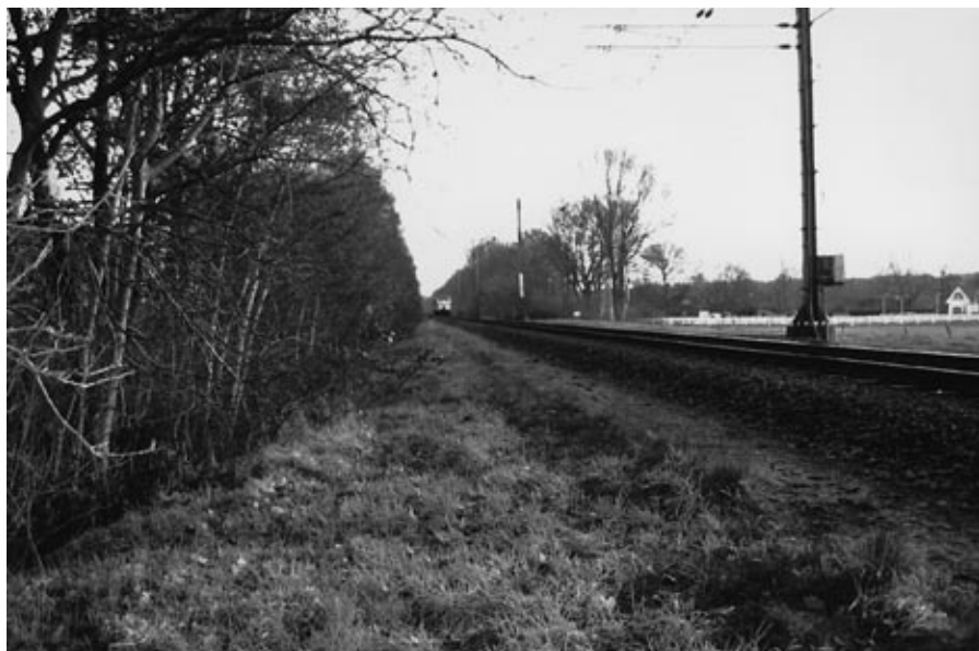
Ongeveer daar waar de trein rijdt, achter Cuneraweg 202, kwam Jan Willem Schouten op 7 mei 1943 om het leven bij het aanbrengen van de dynamietlading aan de rails (foto W.H. Strous, november 2005).
