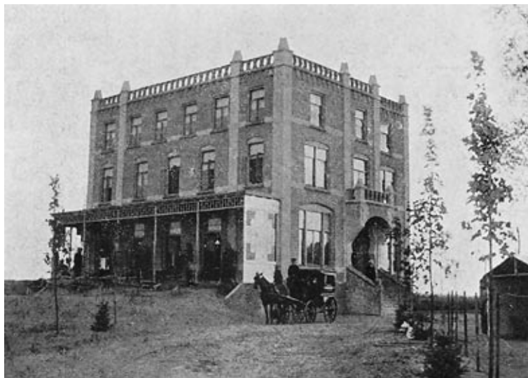
De koets van De Haas bij Berg en Bosch, links de noordgevel met veranda, rechts de westgevel met de hoofdingang. Geheel rechts het pomphuisje van de watervoorziening, 1908
