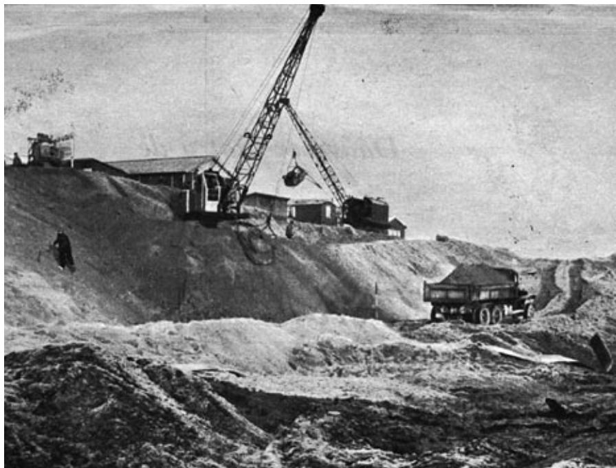
De verbreding van het Spoorgat ten behoeve van de verkeersweg werd omstreeks 1956 met groot materieel aangepakt.
