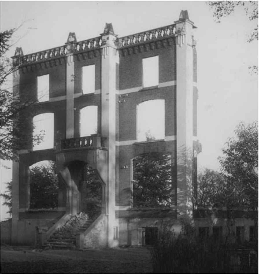
Nadat de Duitse Wehrmacht Berg en Bosch in brand hadden gestoken, bleef slechts de westgevel overeind
