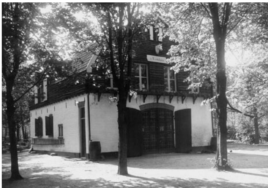
De noordgevel van het koetshuis, 1946. Foto door Henk Lamme
