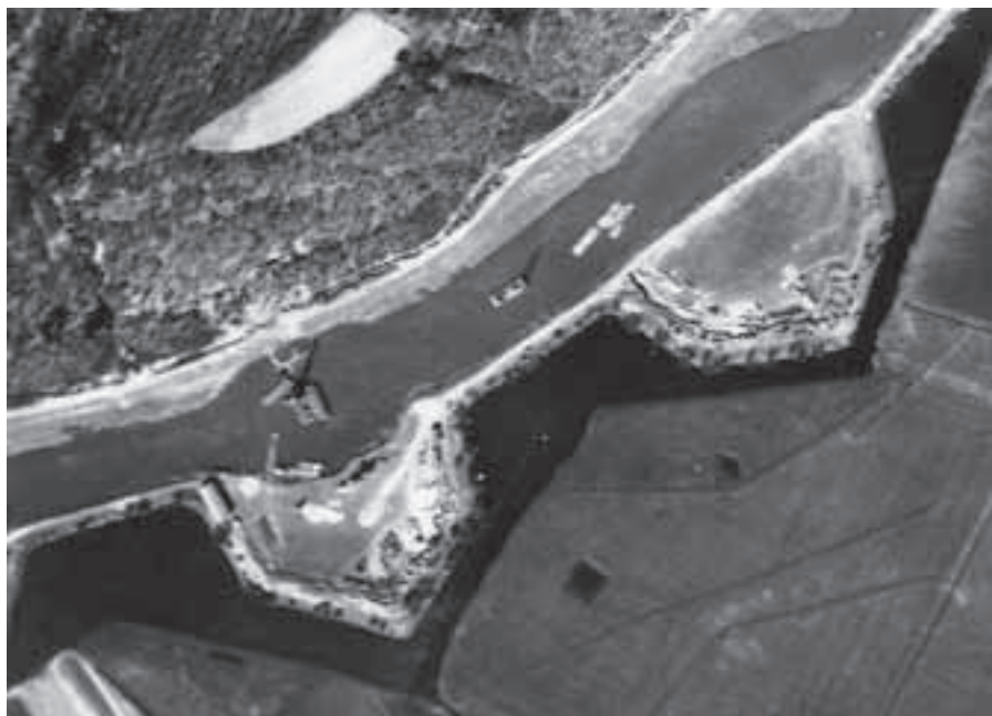
Op dit detail van een luchtfoto van het stellinggebied van het 8e Regiment Infanterie (1940) zijn de bouwput van het gemeal en de bouwkransen goed te herkennen. De bouw vond plaats vanaf het middelste van de drie bastions op de uiterwaard ten oosten van de Grebbeberg. (foto: collectie Nederlands Instituut voor Militaire Historie)
