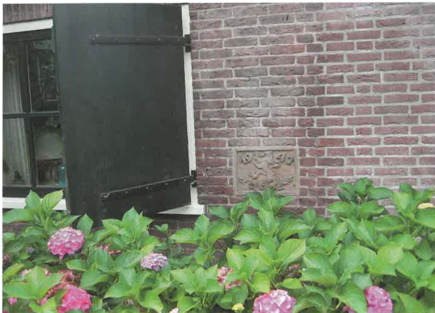
De wederopbouwsteen aan de oostzijde van de voormalige boerderij aan de Weidijk, naast waar eens de voordeur was (foto Willem H. Strous, augustus 2007)
