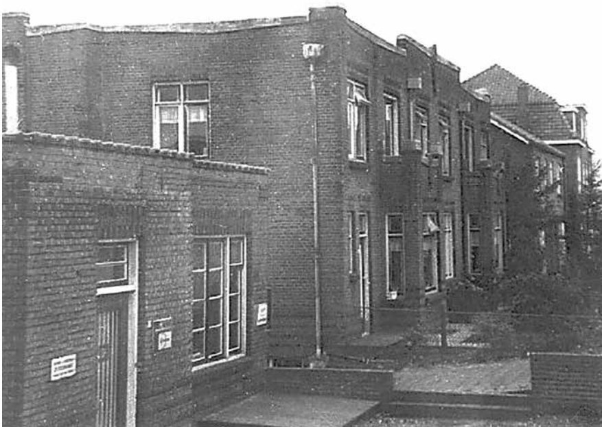
Grebbeweg 10, 12 en 14, woonhuizen van de drie gebroeders
