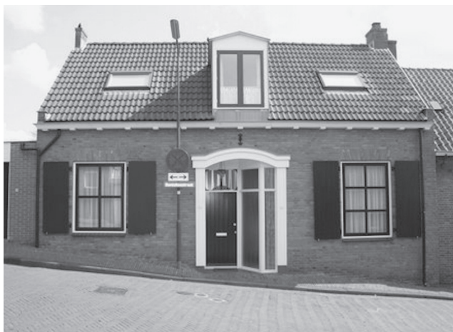
De woning die in de plaats gekomen is van de schuur van Van Waveren.
