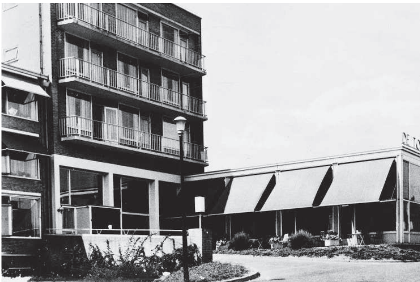
De ingang van de oude Tollekamp.
