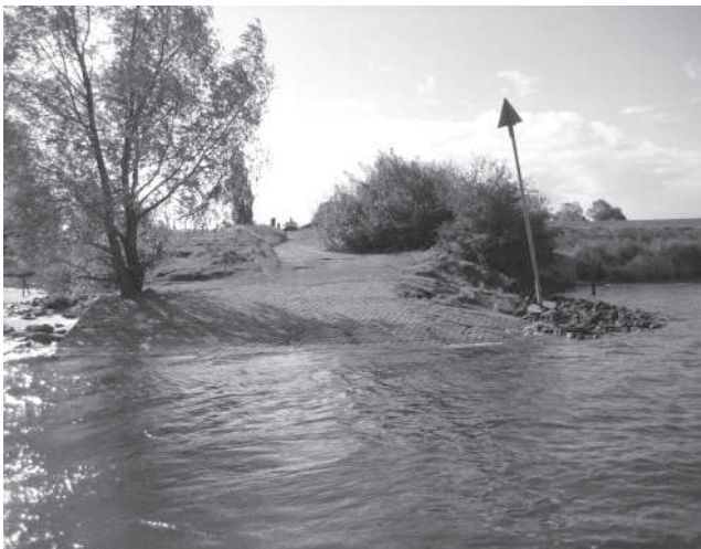
De vervallen veerstoep aan de Betuuse kant van de Rijn tegenover Rhenen, oktober 2010. (foto Willem H. Strous, Rhenen)
