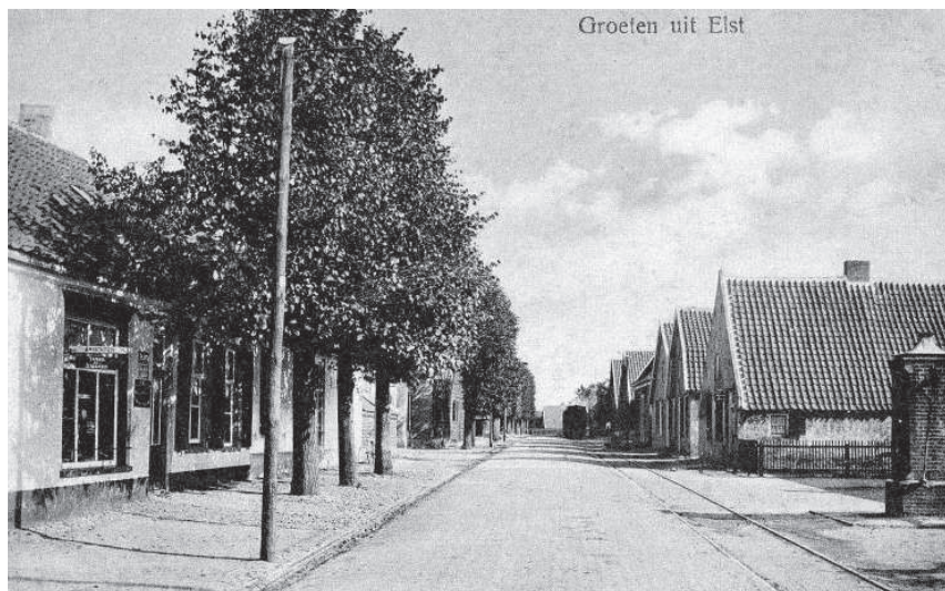
Voor het woonhuis stond een benzinepomp van de American Petroleum Company. Tussen de winkel van Van den Brink en het woonhuis van De Kroon liep het weggetje 'De Steeg'. Links op de foto staat het huis van Nelis van den Brink die ondermeer tabaksland bezat. De garage is afgebeeld in Oud Rhenen 2008 No.3. p.3.
