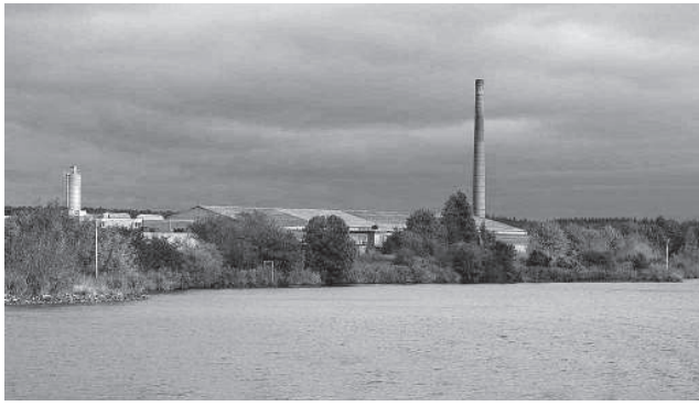
De schoorsteen van de steenfabriek Timmermans te Elst(U). (foto N.G. van den Oosterkamp, Elst(U))
