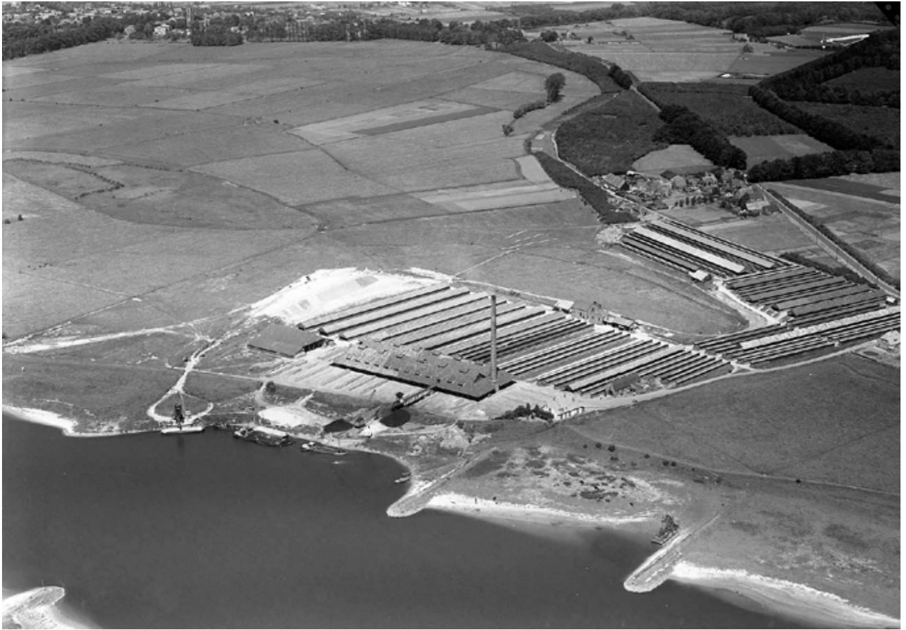
Deze luchtfoto uit 1947 laat de omvang van het fabriekscomplex in die tijd zien. Opvallend is de grote hoeveelheid haagbuiten, waarin de stenen lagen te drogen. Op het terrein rechts was later de kraanmachinistenschool gevestigd. (Collectie KLM Aerocarto, nu Aviodrome Lelystad)
