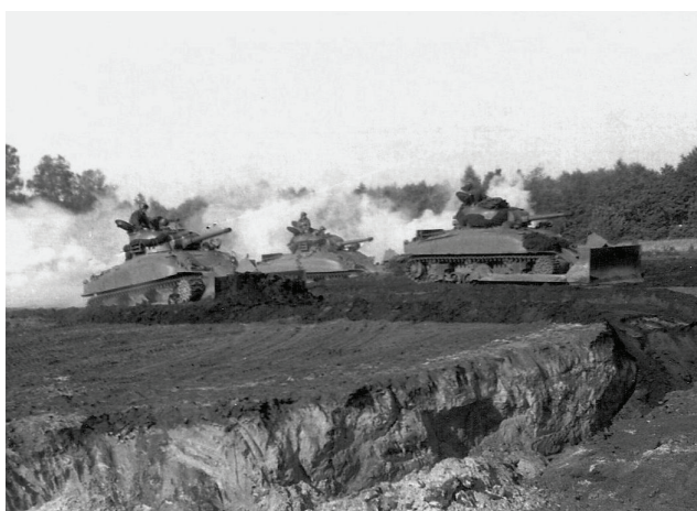
Sherman tankdozers van het 11e Genie bataljon in actie tijdens het dichtschuiven van een tankgracht
