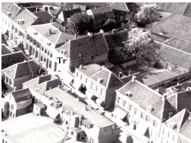
Luchtfoto van het huis 'Trappenborch' anno 1930; aan de achterkant van het voorste gedeelte van het huis is nog een trappevel zichtbaar (foto KLM; fotocoll. H.P. Deys)
