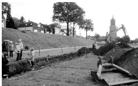
Opgraving aan de Paardenmarkt bij de Veerweg
