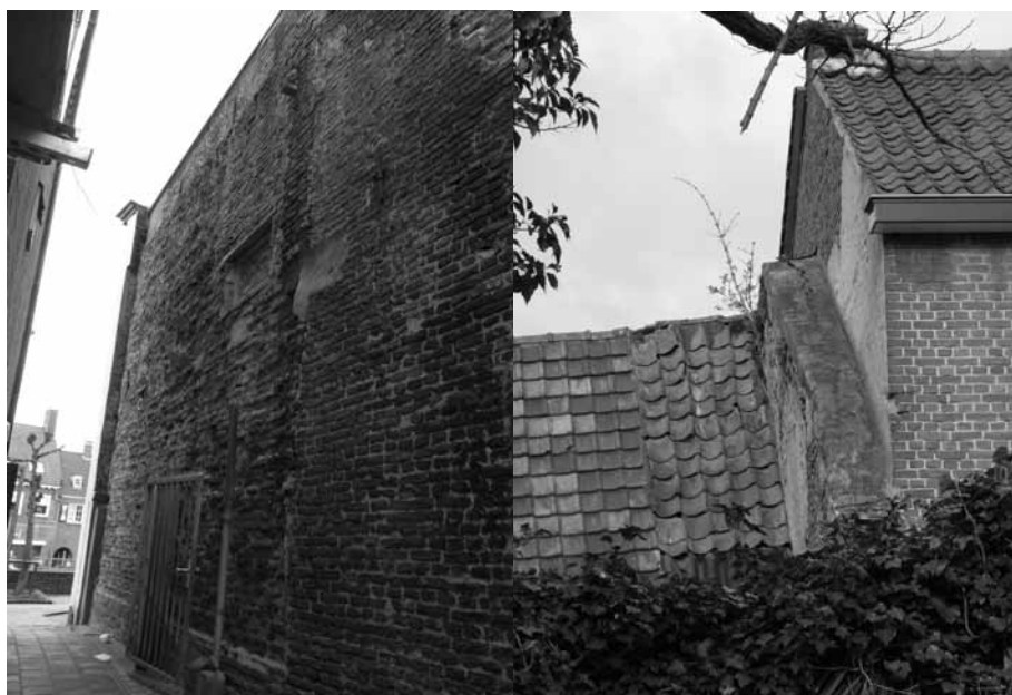
Links: de oude zijmuur van het huidige winkelpand, vroeger St. Christoffel gebeten. Rechts: een gedeelte van een oude dikke muur tegen de zuidkant van het huis Grutterstraat 6 (situatie maart 2014)
