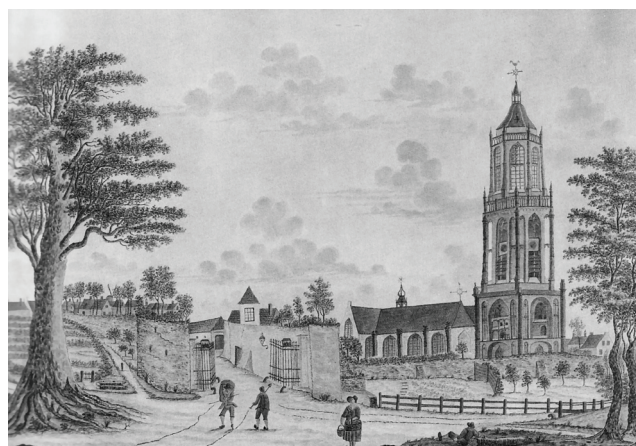
De barrière met bekwerk aan de Westpoort, door C. Haakman anno 1847
