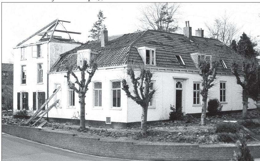
Het Teldershuis tijdens de sloop, 1972
