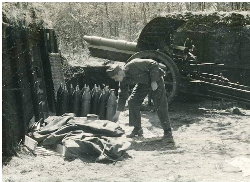
Een houwtser 15.17 van de eenheid van Ballot in een geschutspuut op de Lijstereng te Rhenen. De 45 kilogram zware granaten zijn goed zichtbaar, net als wachtmeester John. (Historische Collectie Korps Veldartillerie 't Harde)
