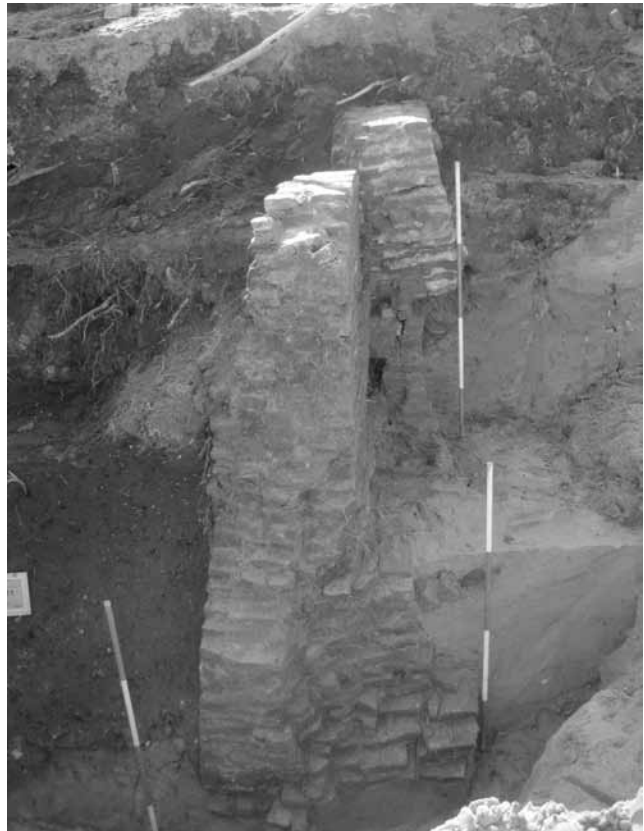
Restant van de keermuur bij de Bergpoort, nu te zien in de parkeergarage (A.J.P.M. Maas, Rhenen)
