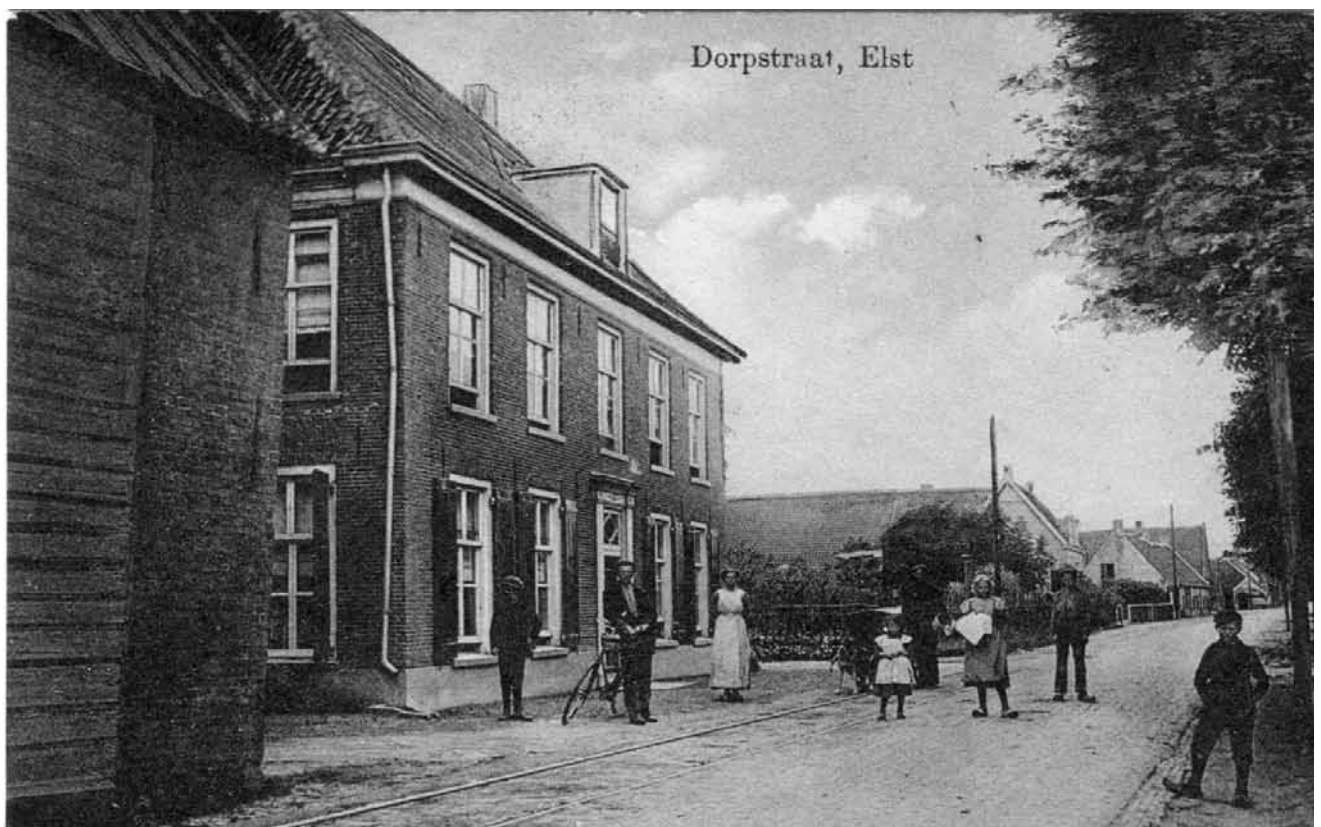
Het pand op de boek Rijksstraatweg-Opslag was Logement de Zwaan. Links is nog een gedeelte van de wisselschuur te zien. Het Logement was begin 19 e eeuw in handen van Huibert van Baren. In 1840 werd het overgenomen door buurman Hendrik de Ridder. Het pand was tot in de tweede helft van de 19 e eeuw in gebruik als logement. Het vertoont grote gelijkheid met Herberg Den Rooden Leeuw in Amerongen, waar zich ook een paardenwisselplaats bevond. (Col. N. van den Oosterkamp)
