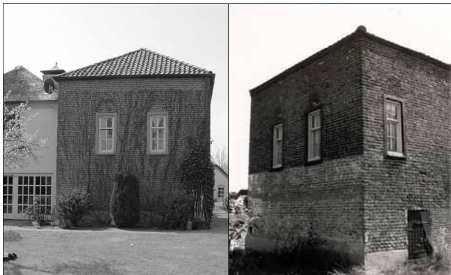
De 'stenen kamer' of 'spijker' van Stuivenes in Achterberg; huidige situatie en direct na de sloop van de oude er tegen aanstaande boerderij (fotocollectie A.J. de Jong)
