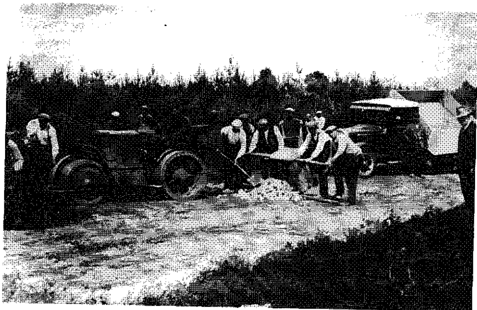
De laatste hand wordt gelegd aan het tweede gedeelte van de Autoweg Remmerden-Rhenen, 1936.
