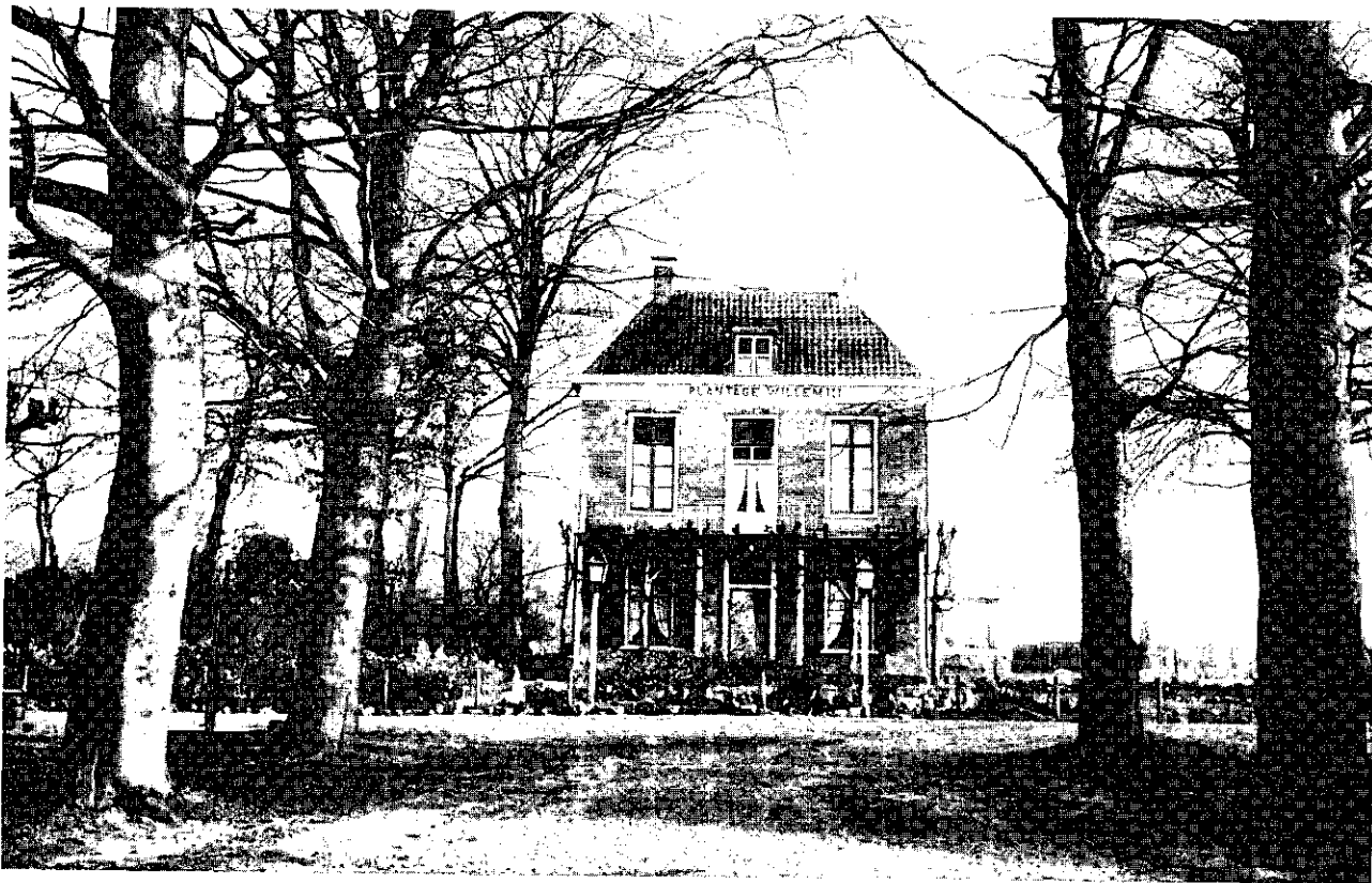
Vooraanzicht van het inmiddels geheel afgebroken herenhuis van het hoofgebouw van Plantage Willem III. Foto 1963.
