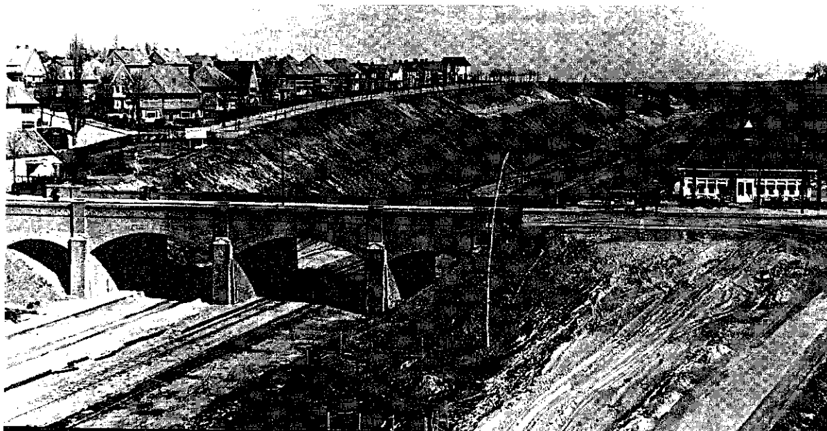
Werkzaamheden aan het traject van de Provinciale weg Veenendaal-Kesteren, de tegenwoordige N233. Nadat de rails zijn gesloopt zal asphalt hier toegang verlenen aan vele duizenden auto's per dag. Let op het spoorwachtershuisje uiterst links, dat vroeger stond aan de oostzijde van de Spoorbaanweg (foto Lamme Veenendaal, ca. 1956)
