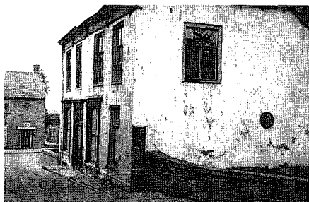
De voorzijde van de woning van de fam. Oldenhof (perceel 263), gezien vanuit de Kerkstraat. De aangrenzende Waag is inmiddels afgebroken, ca. 1949
