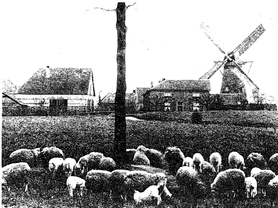
Gezicht op de molen, ca. 1910. De foto graaf moet hebben gestaan vlak ten noorden van het Ruiterpad, waar toen nog geen huizen langs stonden. (richting 1)
