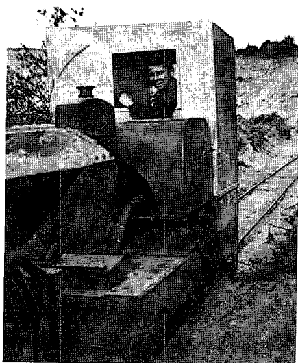
In dit boemeltreintje om de kiepbakjes met zand naar de fabriek (de mengerij) te brengen speelt Willem van den Berg voor machinist. Hij kon ook de dragline bedienen. Juni 1949.
