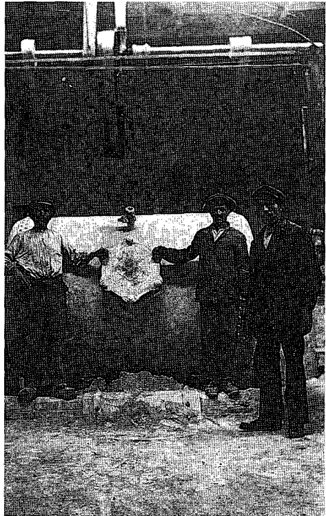
Een nieuwe blustrommel werd op z'n plaats gebracht. Rechts Eef Looijen, een broer resp. oom van de kraan- en draglinedrijvers. 1923.
