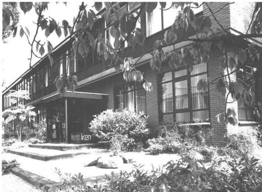
KEMBO aan de Candialaan nummer 8 in begin jaren zeventig. Boven het kantoor aan de voorkant van het gebouw woonde eerst nog Just Meijer. Later werd de kleine toonzaal aan de achterkant over de verdieping uitgebreid.
