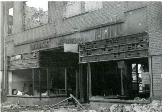
Garage aan de Herenstraat
