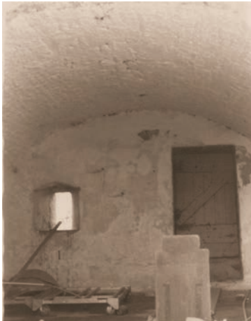
De onderste verdieping van de ‘stenen kamer’ Stuivenes in Achterberg, een opslagruimte met tongewelf (foto J.Th.M. Mom)
