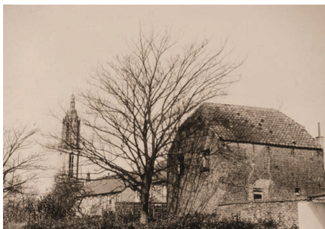
De schuur bij de Tijmenstoren die circa 1990 is afgebroken
