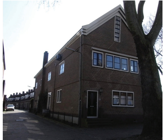
De kruidenfabriek aan de Van Deventerstraat verbouwd tot drie appartementen; situatie 2023
