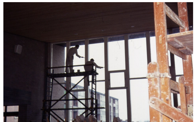
Het plaatsen van de grote ramen in de kerkzaal (foto ds. P.L.J. Wapenaar, Voorburg)
