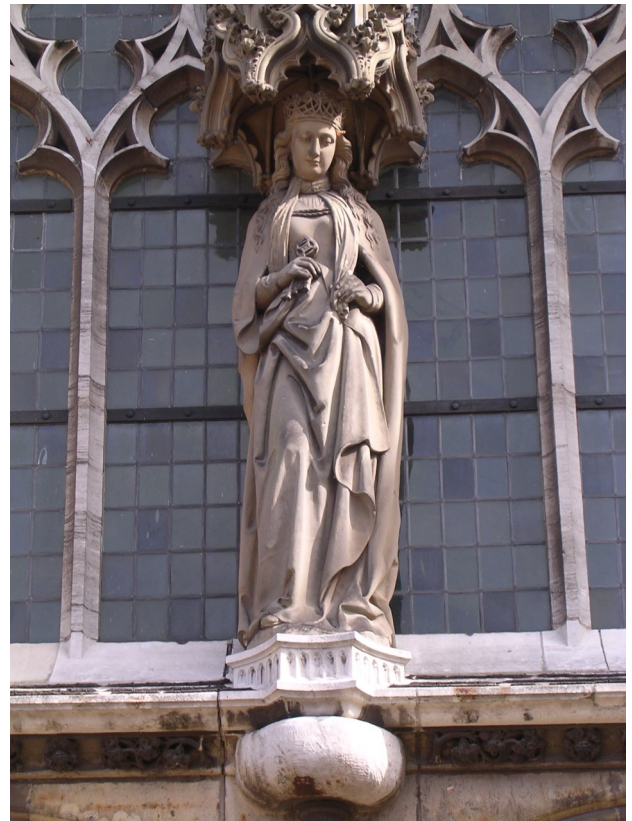
Cunerabeeld, Cunerakerk 1897, atelier Cuypers
