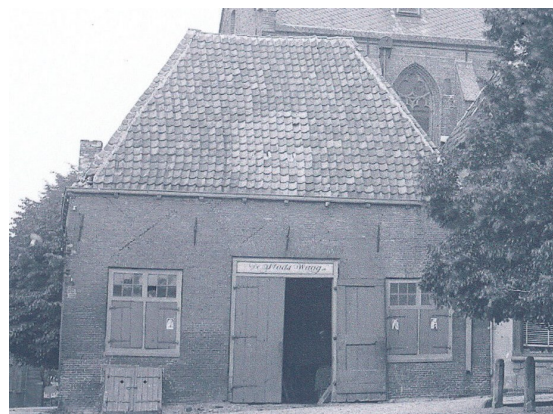
Afb. 8. Het voormalige waaggebouw
